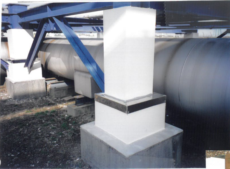
鋼脚部の耐火ボード被覆 コンクリート上面部の金属保護カバー
